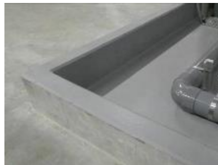
防液堤(排水中継槽)
